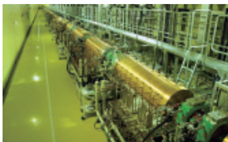
図2 加速器トンネルに設置したACS型加速空洞
